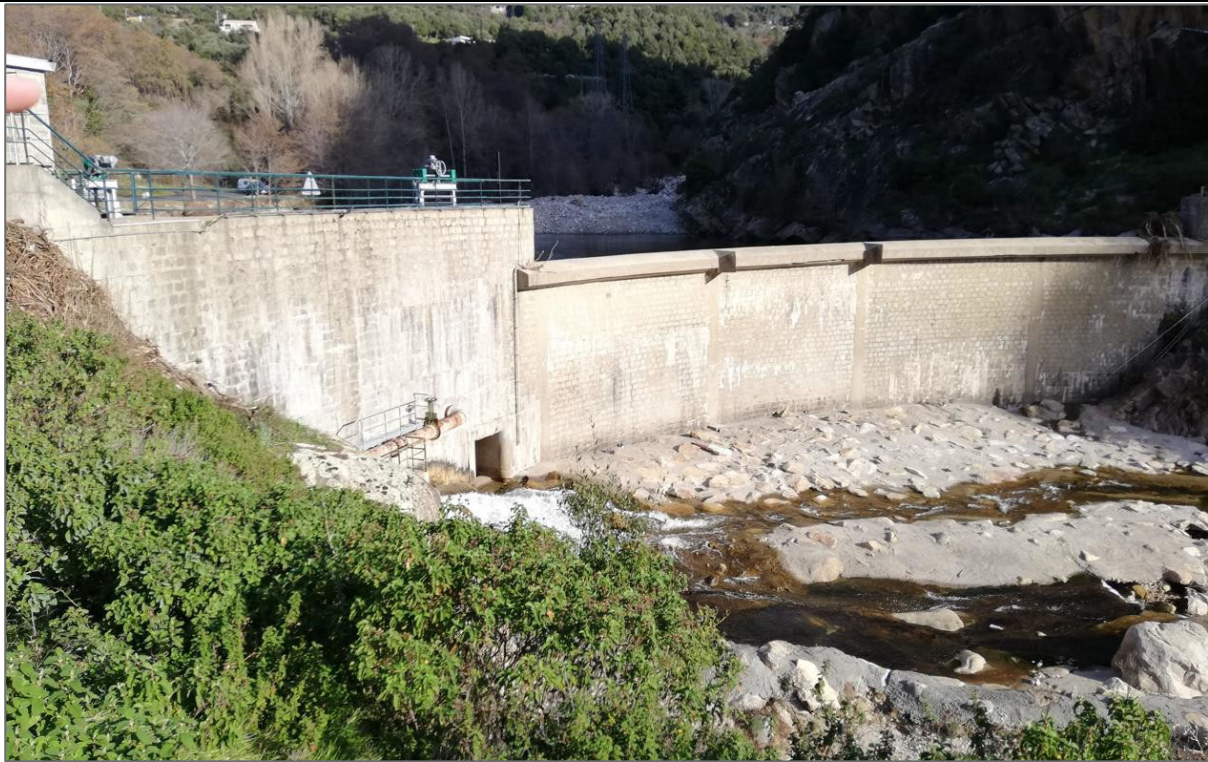
Figure 3: vue depuis l'aval du barrage d'Ocana
